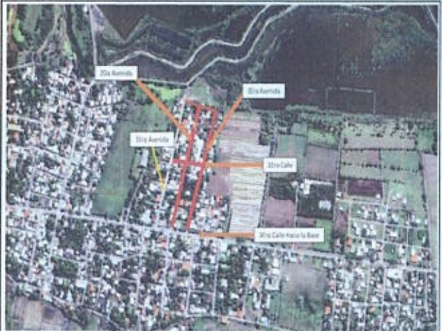
AMPLIACION SISTEMA DE AGUAS PLUVIALES 2DA Y 3ERA AVENIDA COLONIA SAN CARLOS SIPACATE ESCUINTLA.
